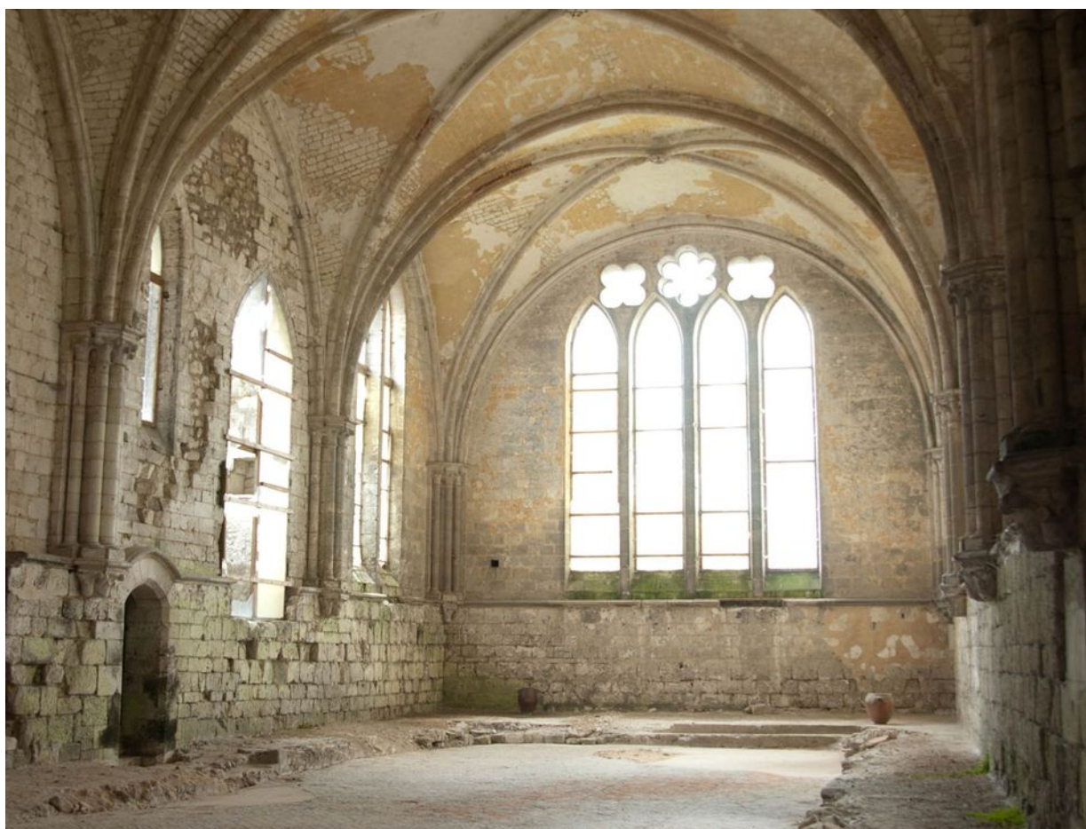
Abbaye cistercienne de Bonport fondée en 1189 (Pont-de-L'Arche).
